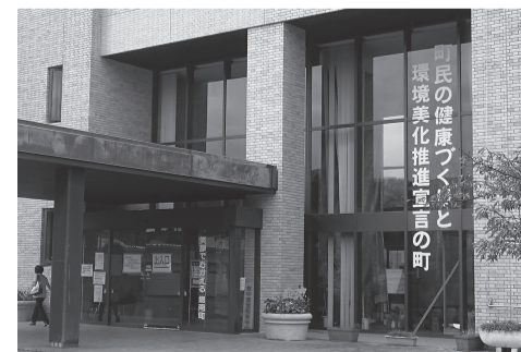
▲被災した鋸南町庁舎
