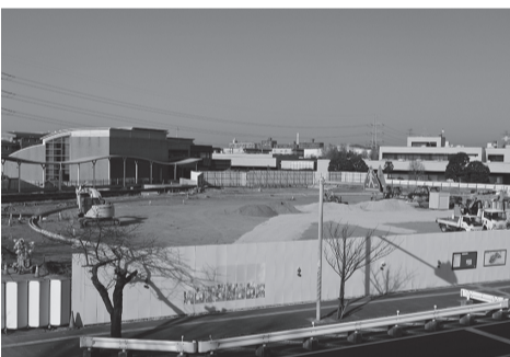
▲現在建設中の浦安公園
