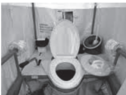
▲女性子供向けの改良後災害用トイレ
